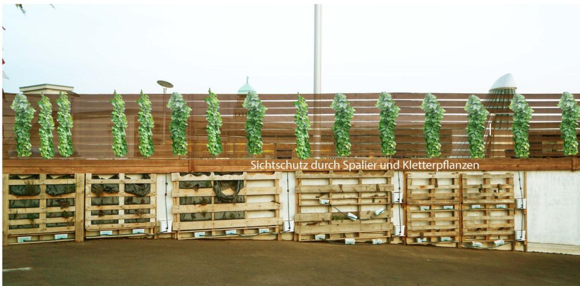
Abbildung 6: Spalierbeete, Aufbau und Sichtschutz
