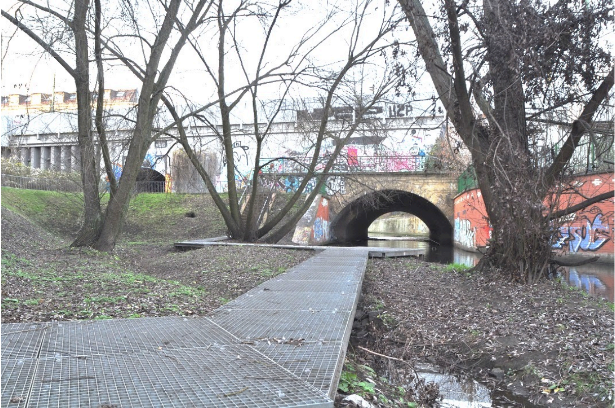
Abb. 10: Blick auf Steg und S-Bahnbrücke
