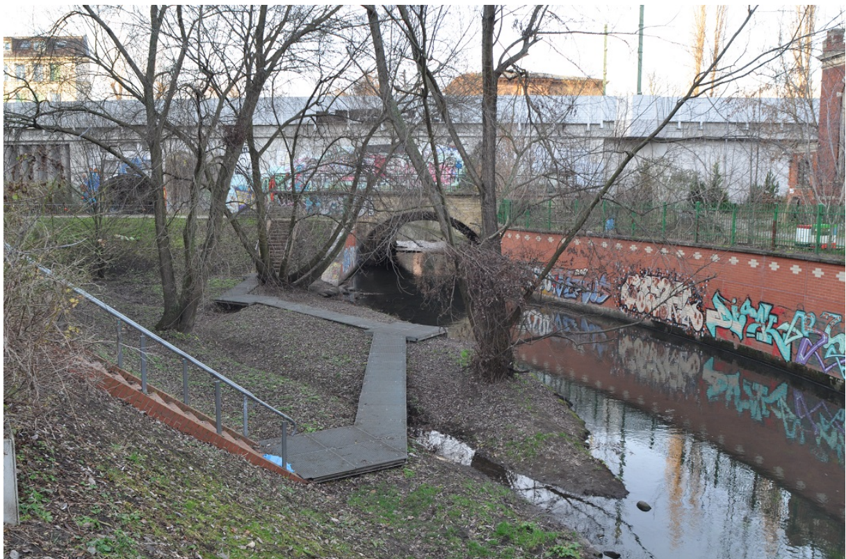
Abb. 9: Blick auf die Projektfläche von Süden
