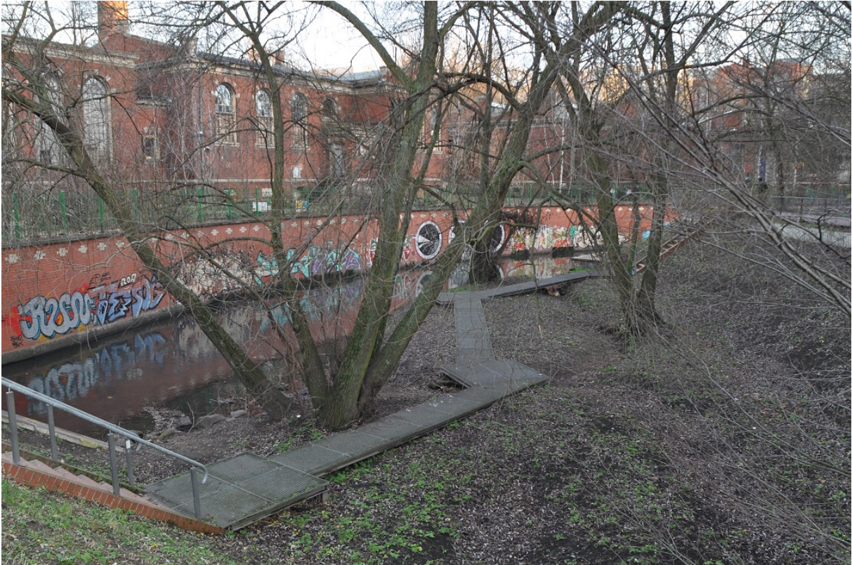
Abb. 11: Blick auf die Projektfläche von Norden
