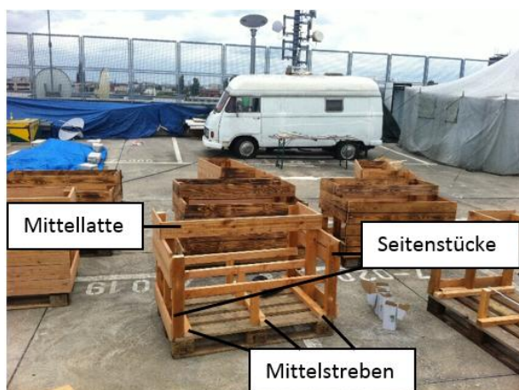
Abbildung 2: Grundgerüst der Pflanzkästen mit Seitenstücken
